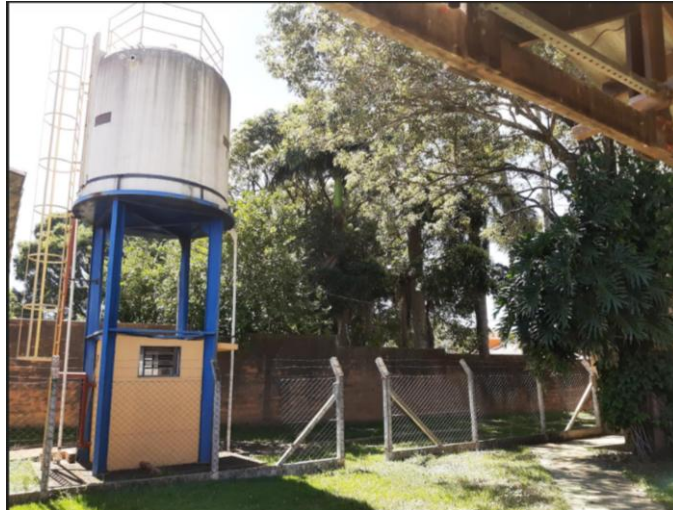
Figura 78. Detalhes da caixa de água (25 mil litros) de fibra de vidro que atende a demanda de água da UBS de Tanquinho.
