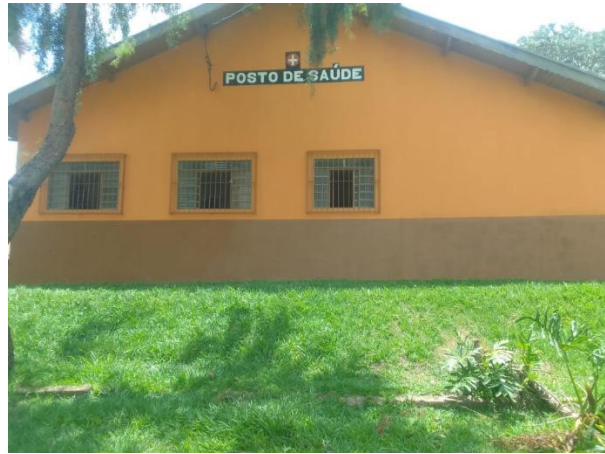
Figura 7. Detalhes da fachada da UBS de Tanquinho, vista da Rua Américo Faganello.
