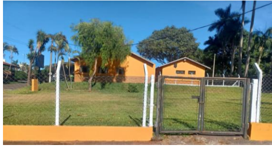
Figura 29. Detalhes da fachada da UBS de Tanquinho.
