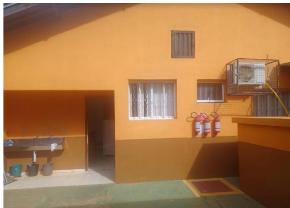
Figura 9. Fachada da fachada da área de serviços da UBS de Tanquinho
