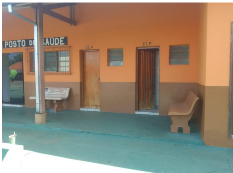
Figura 93. Detalhes da fachada Principal da Unidade Básica de Saúde de Tanquinho.
