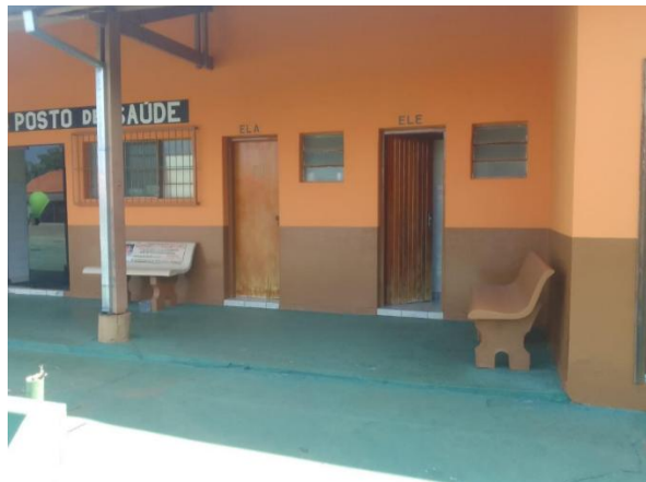
Figura 8. Fachada principal e de acesso a Unidade Básica de Tanquinho
