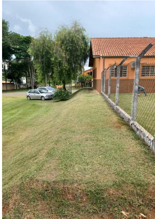
Figura 76. Detalhes da organização e limpeza da área externa da UBS de Tanquinho.
