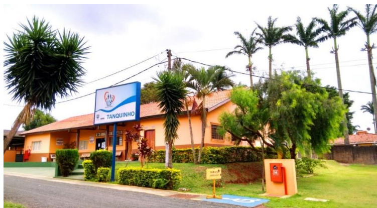
Figura 01. Fachada da Unidade Básica de Saúde de Tanquinho (área do CRT – 350 M 2 , dos quais 120 m 2 construído com recursos próprios do CRT)
