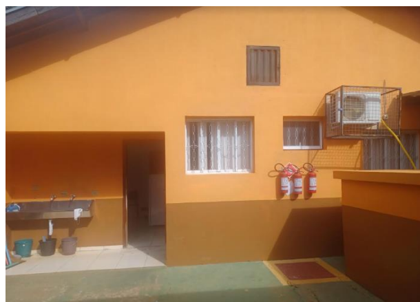
Figura 5. Detalhes da fachada dos fundos da UBS (ar condicionado, área de serviços, extintores e abrigo do compressor odontológico).
