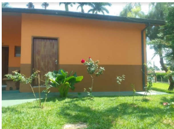
Figura 4. Detalhes da fachada lateral (direita) da UBS, identificando área ampliada (secretaria/atendimento), com recursos do CRT.
