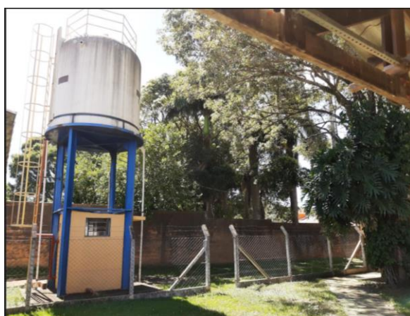
Figura 14. Caixa de água de 20 mil litros, construída pelo CRT, que atende, atualmente, a UBS de Tanquinho.
