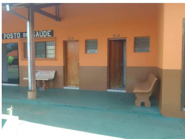
Figura 3. Detalhes da fachada principal da UBS após conclusão da pintura
