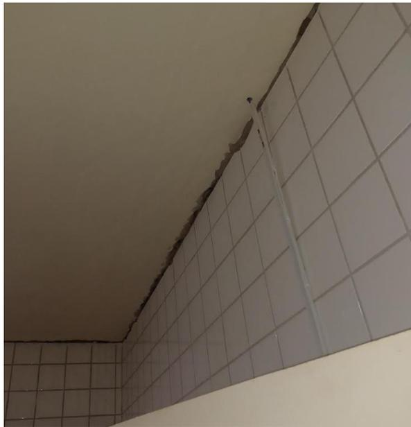
Figura 19. Detalhes da eliminação de trincas na UBS de Tanquinho – sala de vacinas (7/12/2024)
