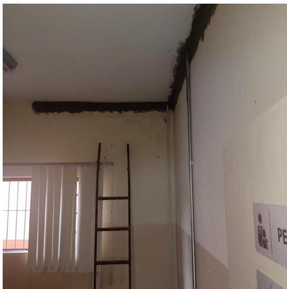
Figura 18. Detalhes da eliminação de trincas na UBS de Tanquinho (consultório)
