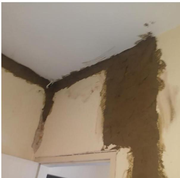
Figura 17. Detalhes dos serviços de eliminação de trincas na sala de vacinas da Unidade Básica de Saúde de Tanquinho (7/12/2024)
