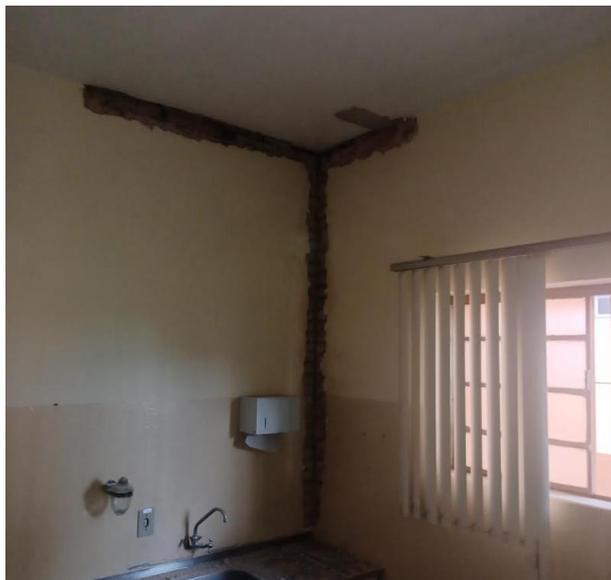
Figura 21. Detalhes dos serviços de eliminação de trincas na UBS de Tanquinho.
