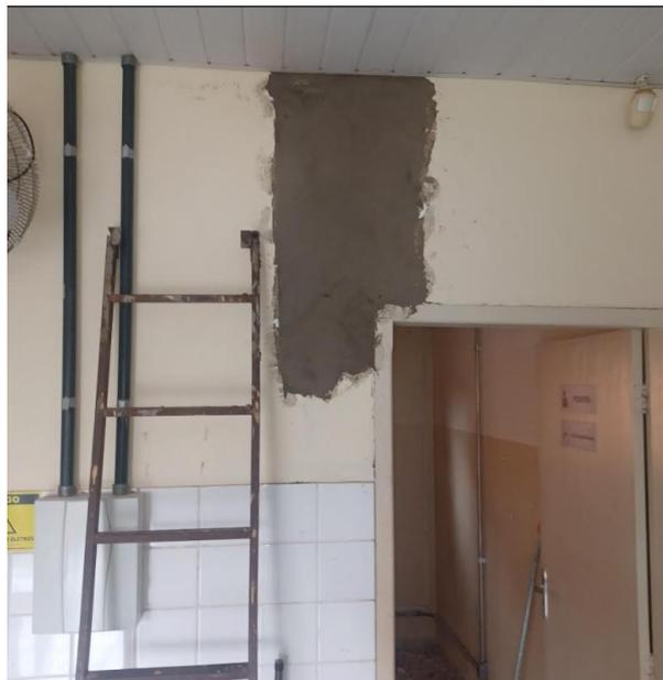
Figura 20. Detalhes da eliminação de trincas na sala de espera da UBS de Tanquinho (7/12/2024)
